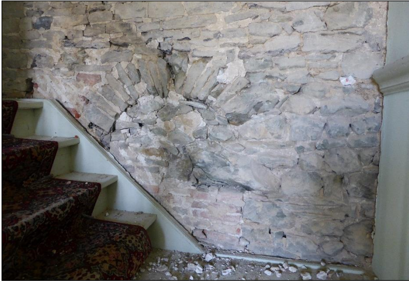
Foto van de ontlastingsboog en de bovenzijde van de (gedichte) deuropening.
